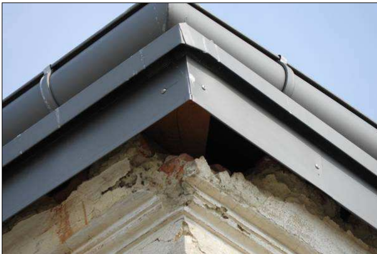
Příklad jednoho z nejvíce poškozených míst zdiva v oblasti podstřeší (roh na okraji dvora).
