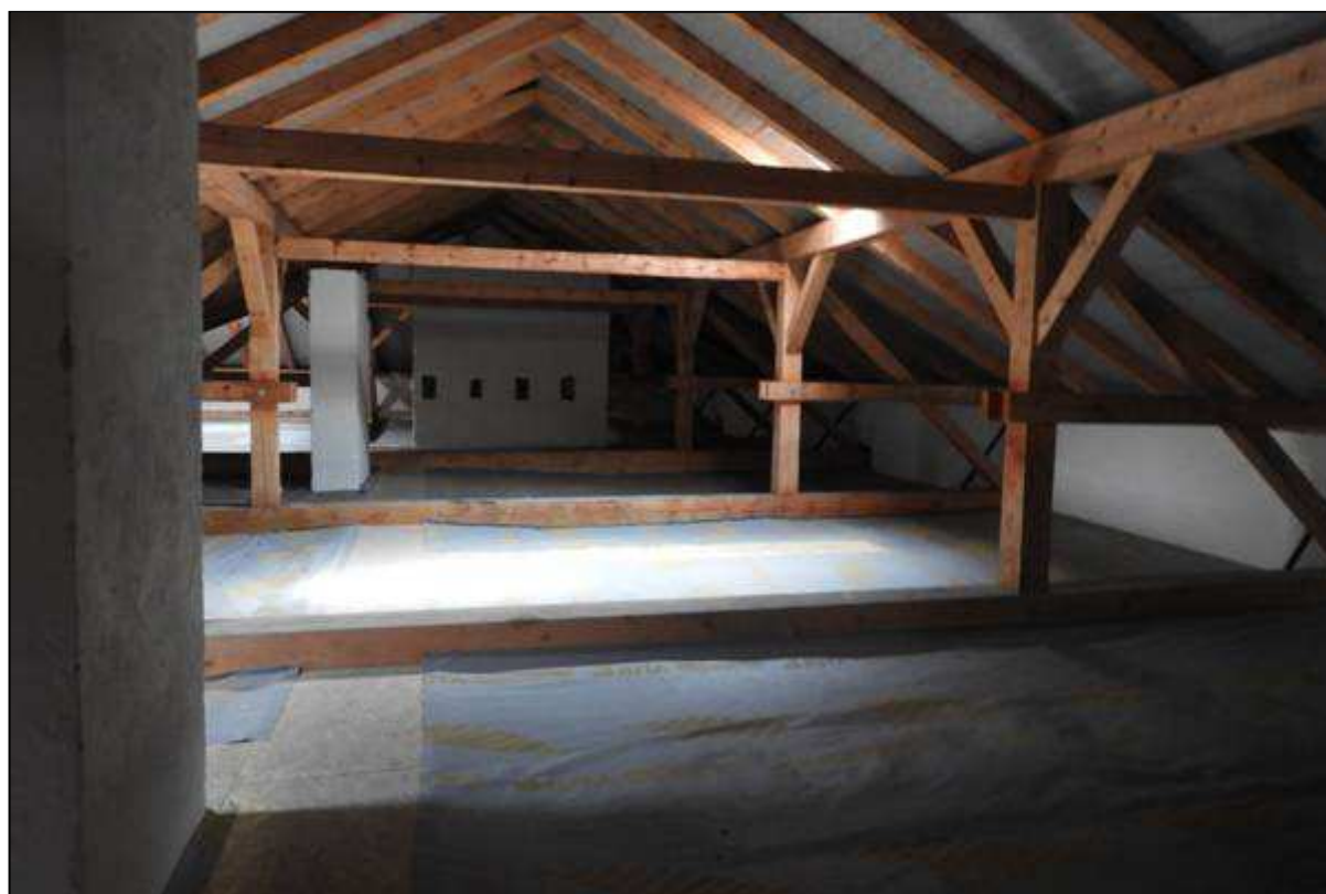
Pohled na půdní prostor pod renovovanou střechou a na zateplení podlahy.
