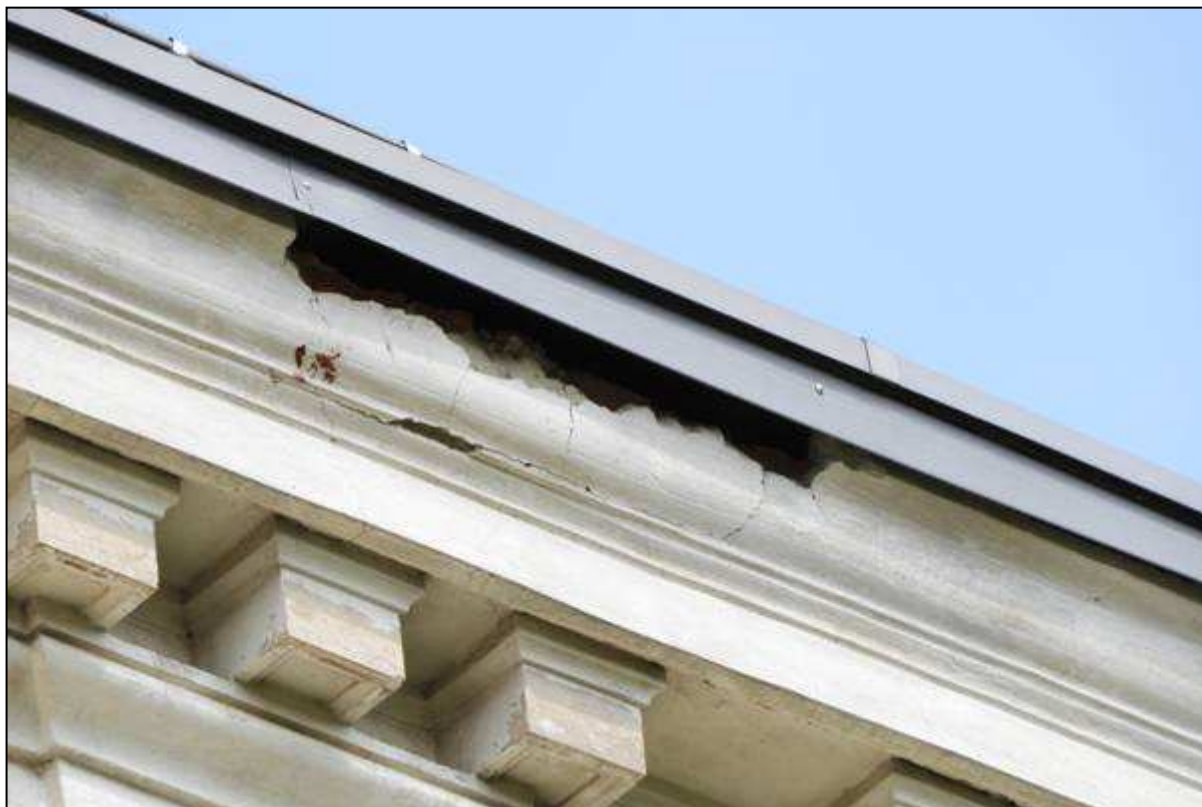
Další příklad poškození zdiva v oblasti oplechování – západní stěna budovy.
